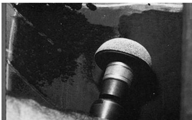
36. Подготовка внутренней поверхности, под заплату;
