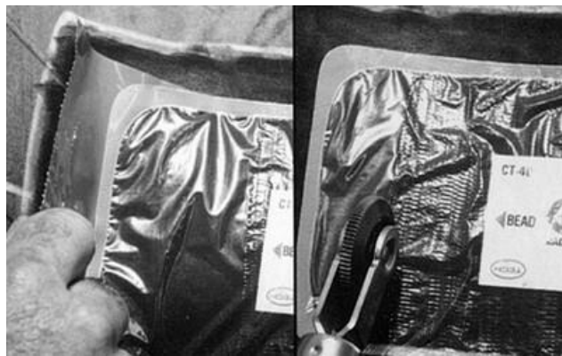
43. Полное удаление нижней защитной пленки, прокатка краев;
