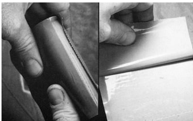
40. Частичное удаление защитного слоя;
